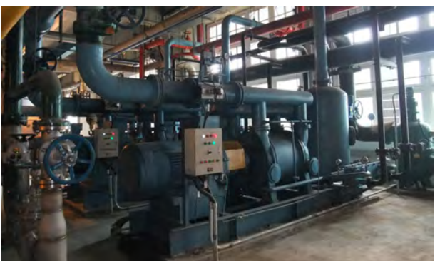
贵州兴义电厂2×600MW机组
